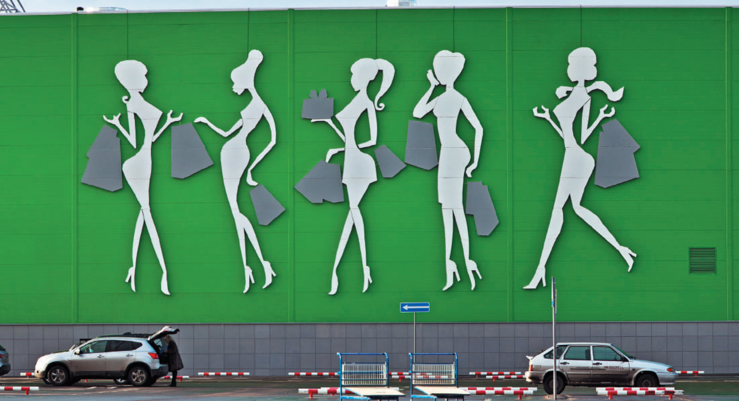
Торговый центр «Седьмое небо» 20 000 м 2 г.Нижний Новгород, 2011 год
